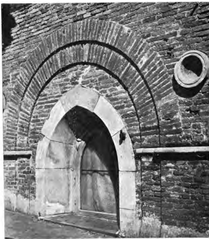
Bild 6. Fenster der Südseite. Äußeres.
